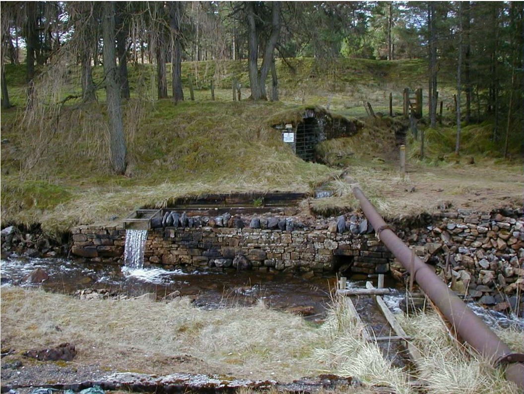
Capelcleugh Adit (N2)
